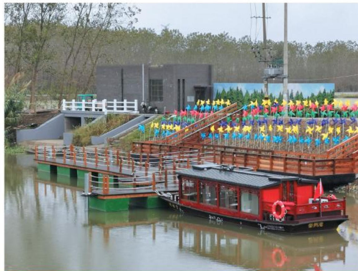
溱湖水上游线码头工程 包含两个码头，面积约 180 平方米。本码头由玻 璃钢浮箱 + 成品钢结构主架 + VVL 塑木面层组装而成。
