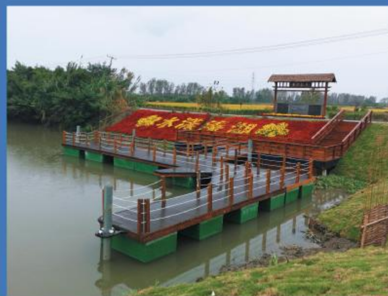
溱湖水上游线码头工程 包含两个码头，面积约 180 平方米。本码头由玻 璃钢浮箱 + 成品钢结构主架 + VVL 塑木面层组装而成。
